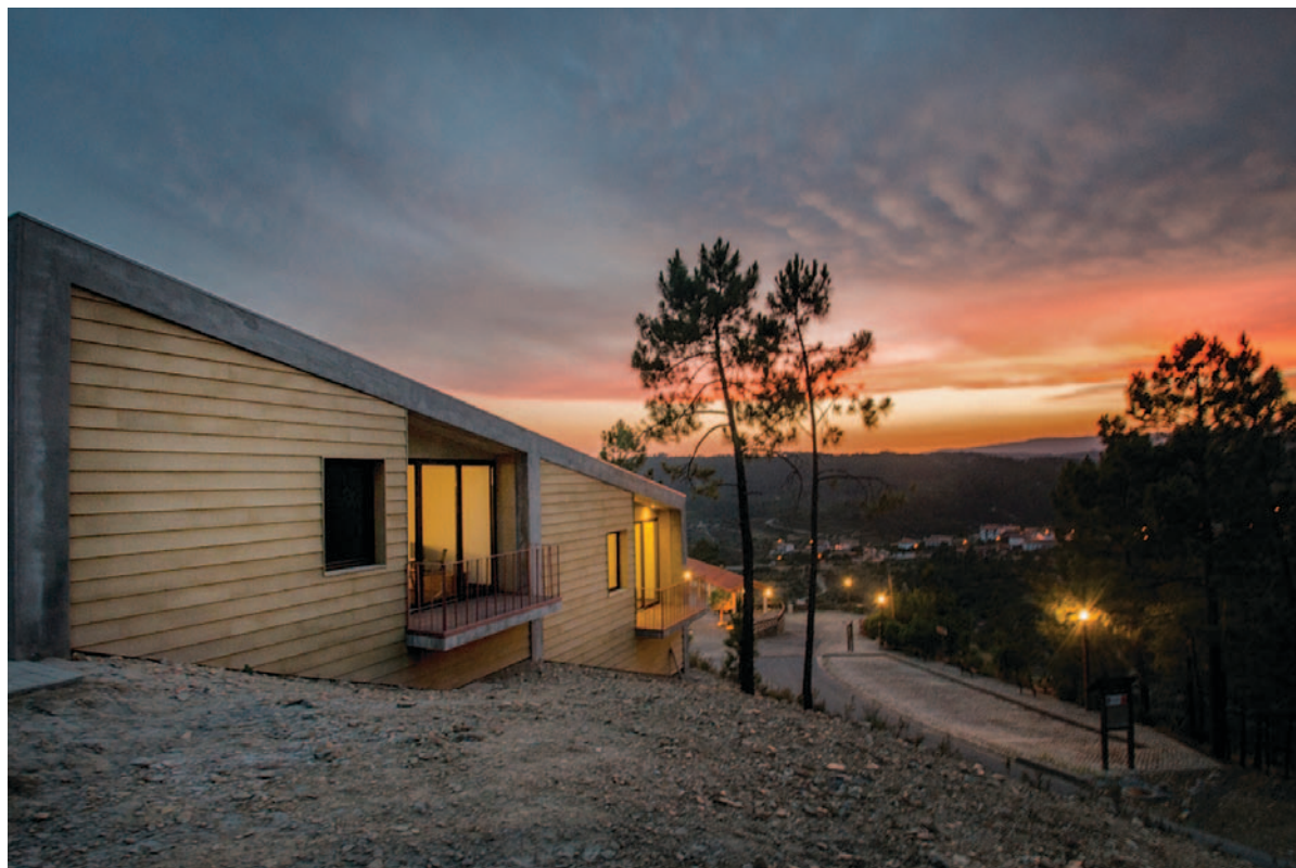
Ventilated Facades – Viroclin | MB-Arquitectos | Beira Baixa, Portugal
