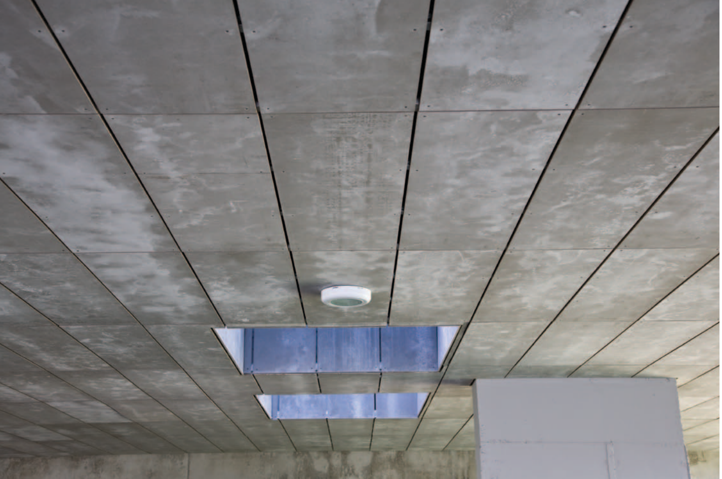
Grey Viroc suspended ceilings | Escola Barrio de la Paz | Estructuras Aragón | Zaragoza, Spain
